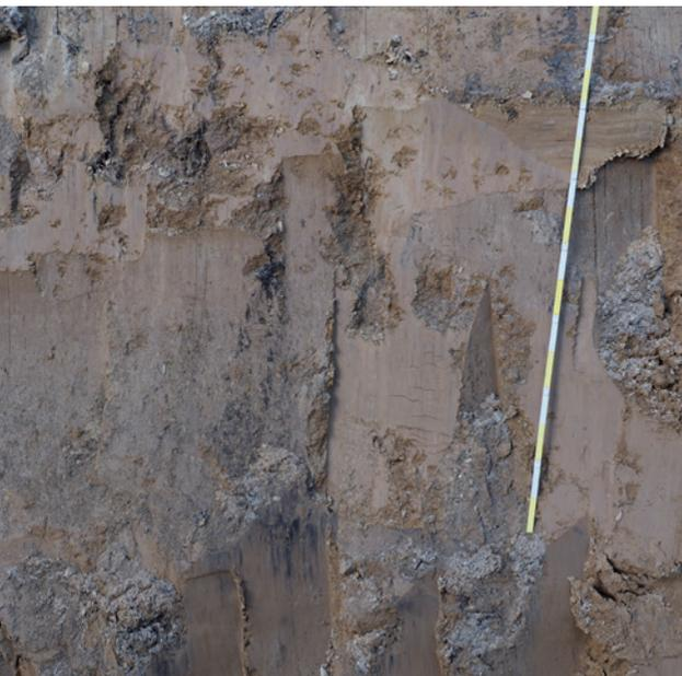
Die Baugrube für die Löschwasserzisterne am Ziegenrücken besteht aus mehrere Meter dickem Lößlehm.
