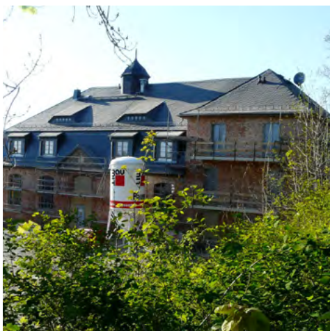
Der Putz ist ab! Inzwischen ist auch die frische Farbe getrocknet.
