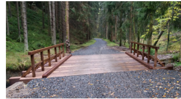
Eine der neuen Brücken und die neue Oberfläche des Forst-, Rad- und Wanderwegs aus dem Khaatal (Kyjovské údolí) nach Hemmehübel (Kopec) im NLP Böhmisches Schweiz.
