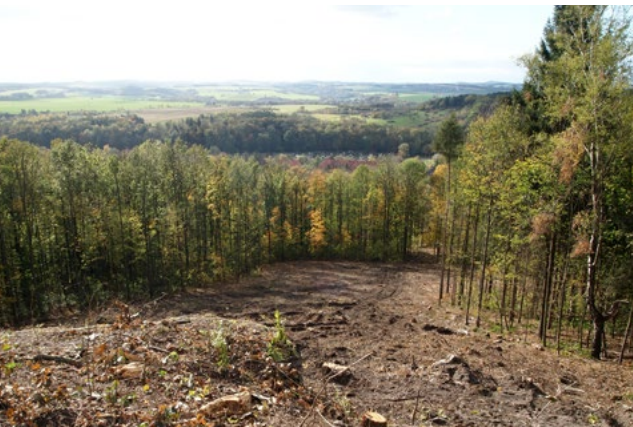
Die Schneise ist gelegt für Pirnas neue Südumfahrung. Der hier in 4 Jahren rollende Verkehr wird auch das Mobilitätsmanagement fordern.
