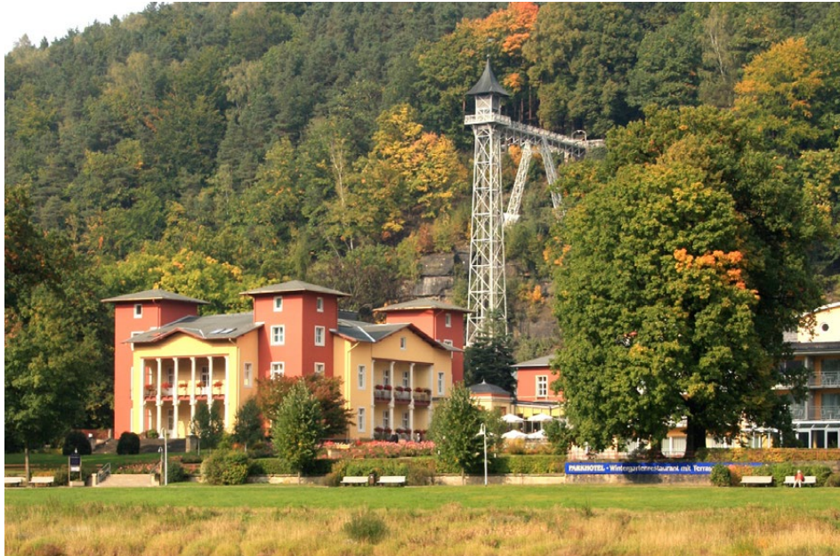
Eine Villa mit 4 Türmen: Das Parkhotel liegt direkt an der Elbe. Seit 1905 erschließt der dahinterliegende 50 Meter hohe Aufzug den Ortsteil Ostrau.
