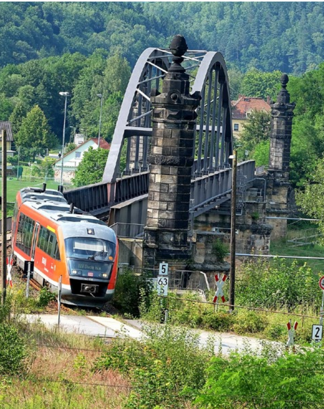
Die neue Nationalparkbahn auf der Eisenbahnbrücke in Bad Schandau
