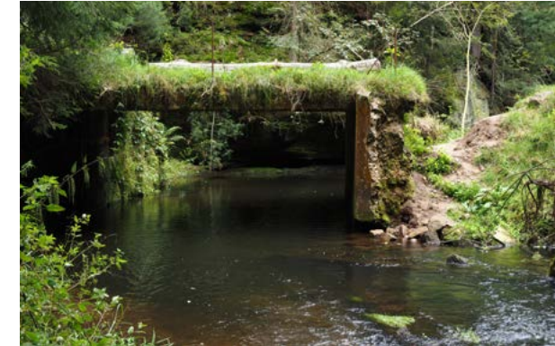
Die Reste der ehemaligen Brücke an der Niedermühle waren schon einige Zeit nicht mehr gefahrlos begehbar.
