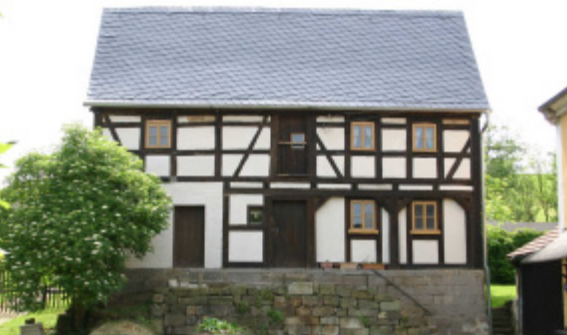
Umgebinderhäuser in Cunnersdorf ...
