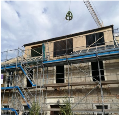
Richtfest am Schützenhaus Stolpen
